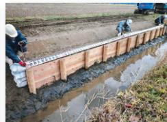
用水路溝畔補修
