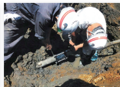
パイプライン補修
