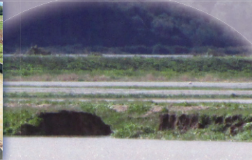
上沼承水溝管理用道路寸断
