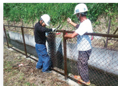
ネットフェンス補修
